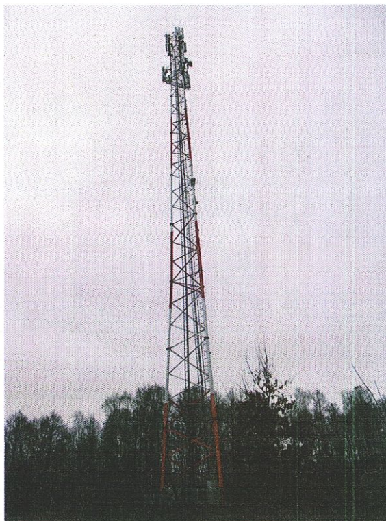
ZaŃ. nr 1: Widok ogólny instalacji radiokomunikacyjnej.
