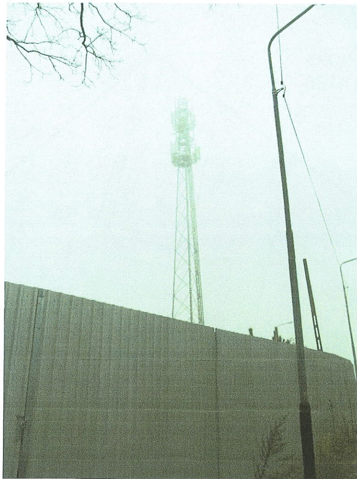
Załącznik nr 1: Widok ogólny instalacji radiokomunikacyjnej.
