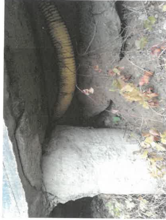
Palisada z pali betonowych zwieńczona oczepem żelbetowym odsłonięta skutkiem zapadnięcia się gruntu na zboczu między palisadą a korytem Potoku Zgórskiego
