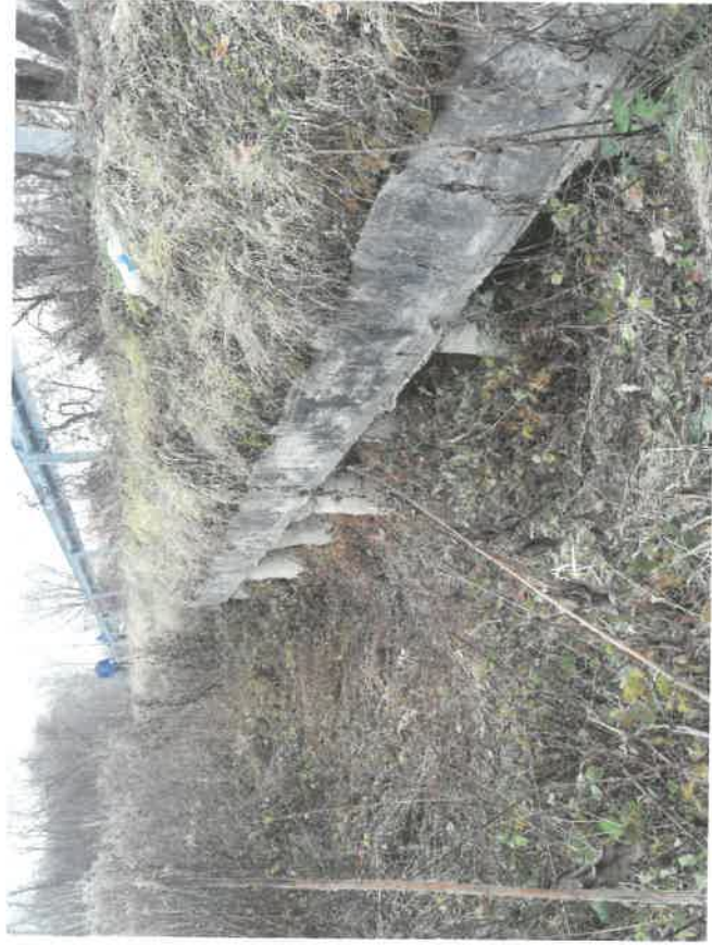
Palisada z pali betonowych zwieńczona oczepem żelbetowym odsłonięta skutkiem zapadnięcia się gruntu na zboczu między palisadą a korytem Potoku Zgórskiego
