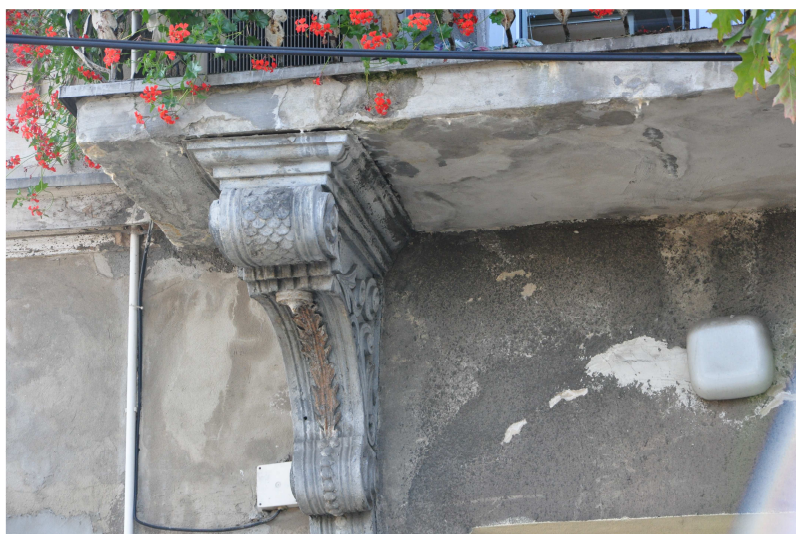
Widok wspornika płyty balkonowej
