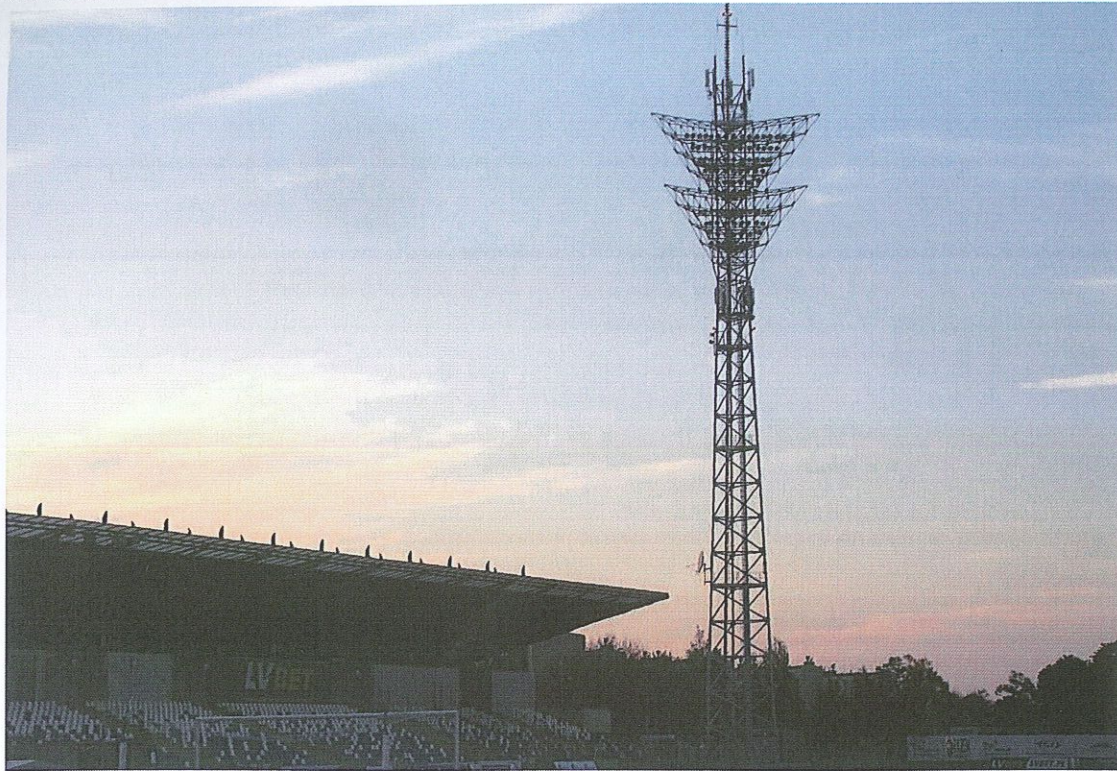
Fot. 1. Stacja Nadawcza MOSiR Mielec – widok wieży z antenami
