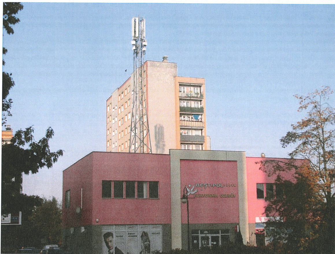
Zał. nr 1: Widok ogólny instalacji radiokomunikacyjnej.
