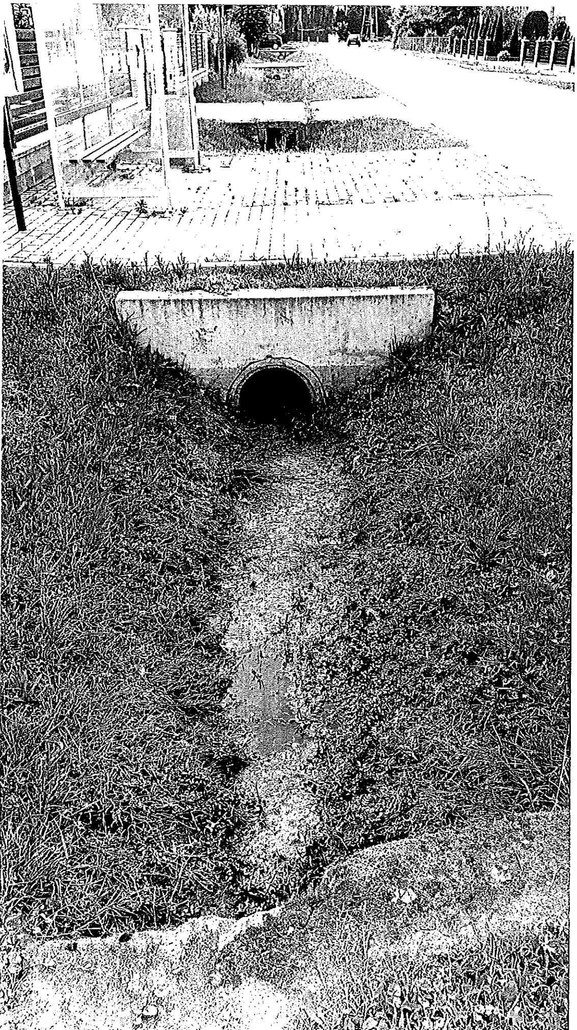
Zdjęcie 5. Rów przy drodze powiatowej nr 1152 R Borowa – Czermin – Przeclaw w miejscowości Czermin (Zawada II) wzdłuż działek od nr 1513/2 do nr 1499/1
