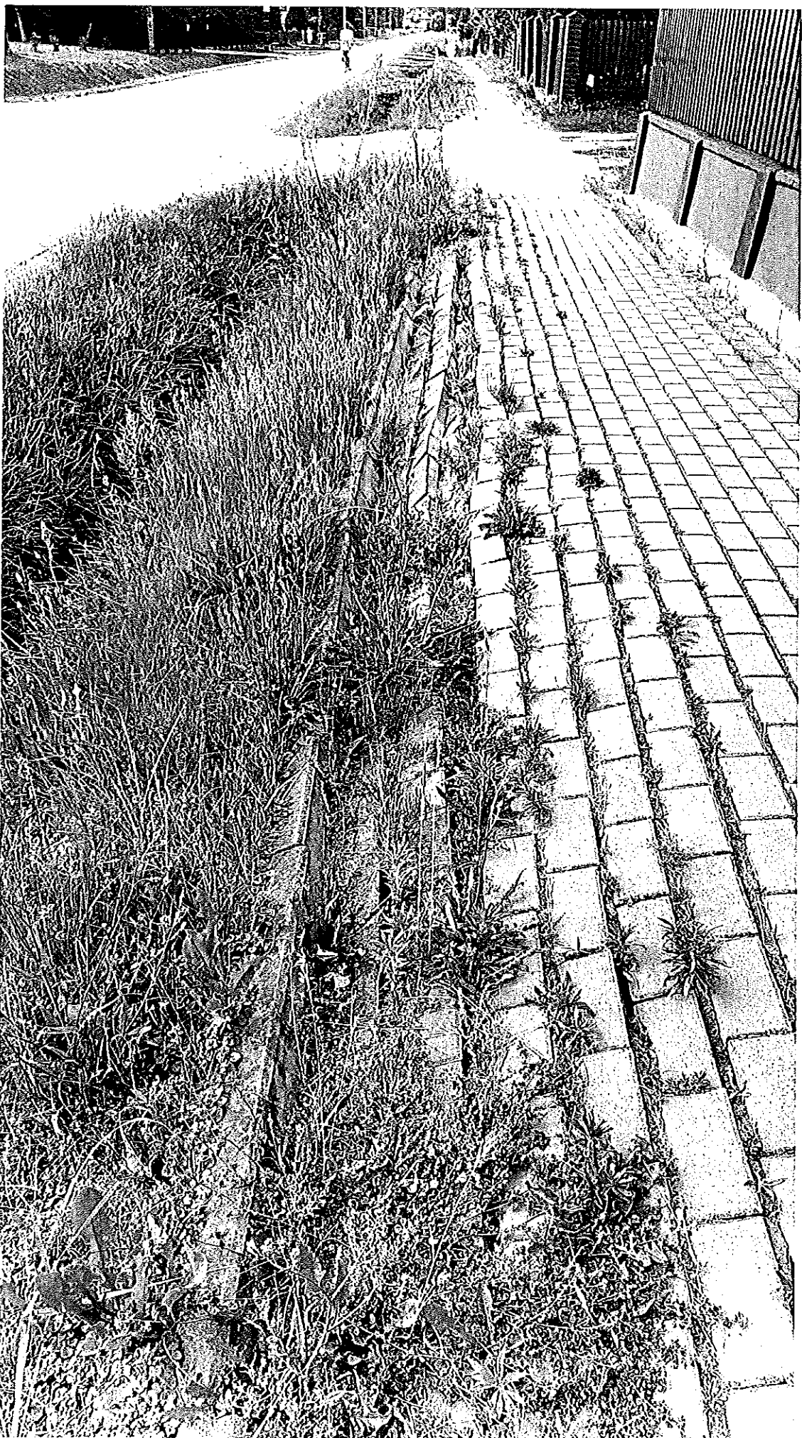
Zdjęcie 2. Chodnik przy drodze powiatowej nr 1152 R Borowa – Czermín – Przedaw w miejscowości Czermín (Zawada I) położony wzdłuż działek od nr 1395/2 do nr 998/3
